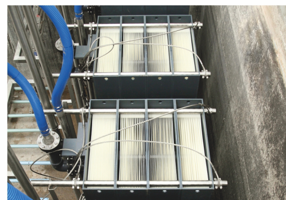
Instalace membránových modulů
